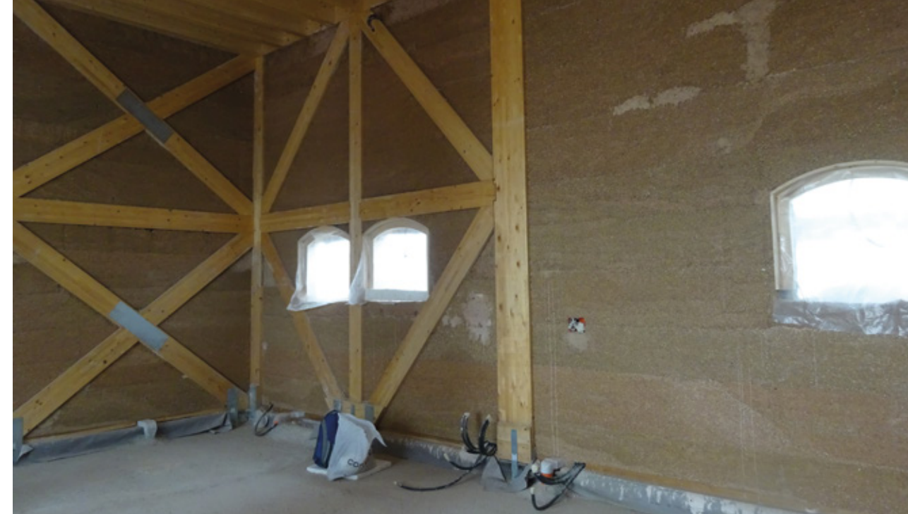
Ricostruzione post sisma Emilia 2012: strutture in legno, muri di tamponamento canapa calce, Cavezzo (MO)
