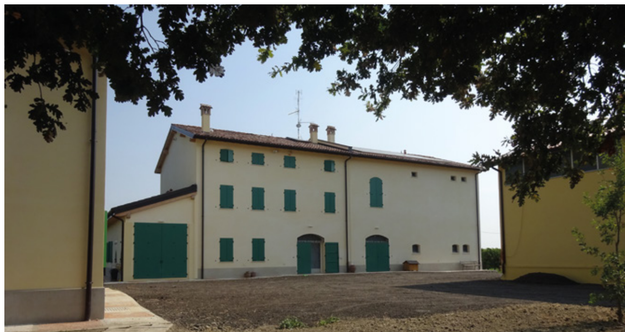
Ricostruzione post sisma Emilia 2012: muri di tamponamento in canapa e calce, abitazione-cantina-acetaia, Ponte Motta (MO)
