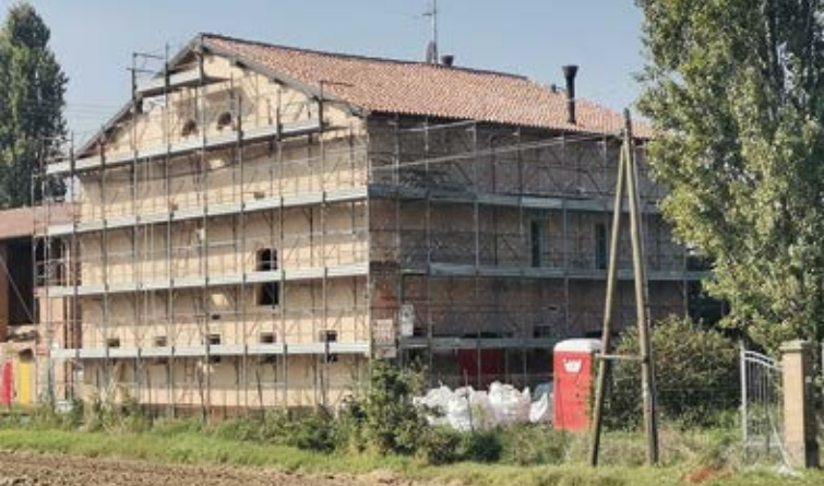
Isolamento esterno “a cappotto” in pannelli di fibre di Canapa, Castelfranco Emilia (MO)
