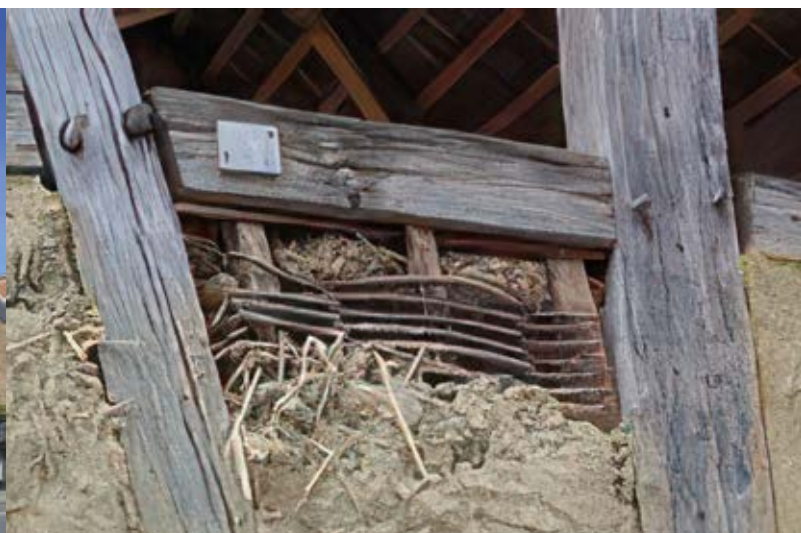
Rennes (F), Place du Champ-Jacquet, “maison a colombages”, particolare tamponamento esterno
